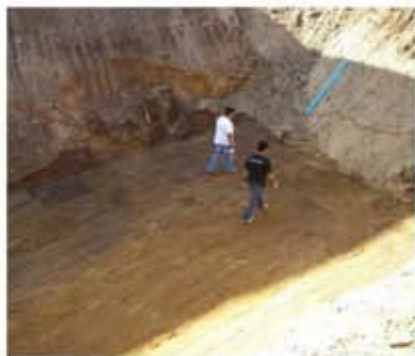
挖掘合适的坑并夯实底部
