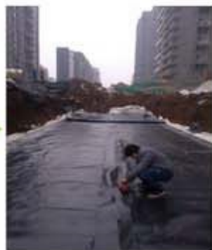
膜铺设及焊接
